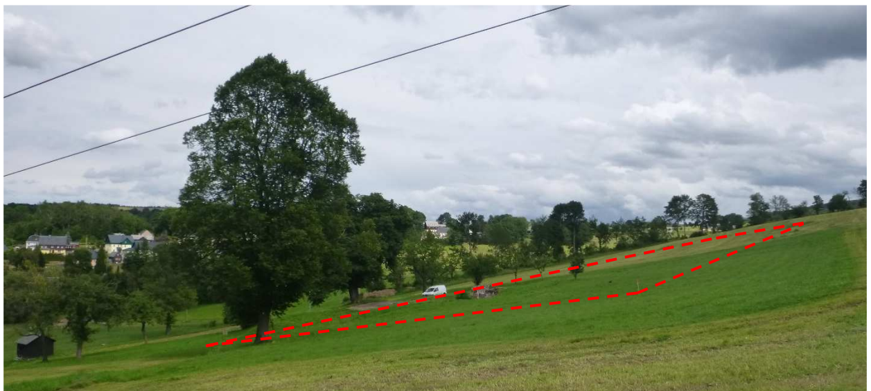
Bild 2: Baustandort in östlicher Blickrichtung
